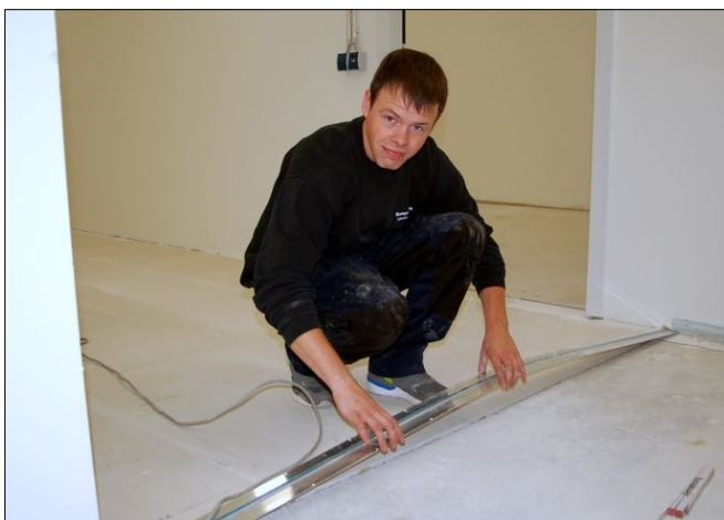
Fußbodenleger David Weilert von der Raumgestaltung Schandert bereitet den Untergrund des Fußbodens zum Verlegen des Finalbelages vor.
